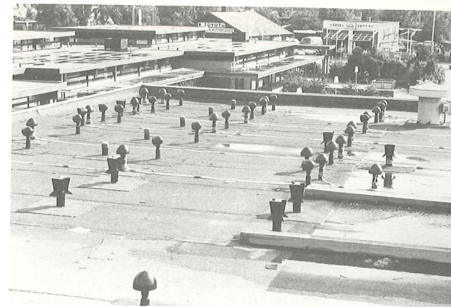
Figur 14. Det sydøstlige hjørne af forsøgstaget med hætter til ventilation, til trykmåling og til måling af fugtindhold. Bagest til højre ses ventilatoren, der benyttes til mekanisk ventilation af område 6.
